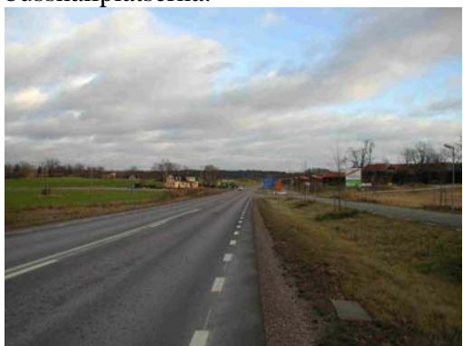
Väg 223 mot Trekanten
