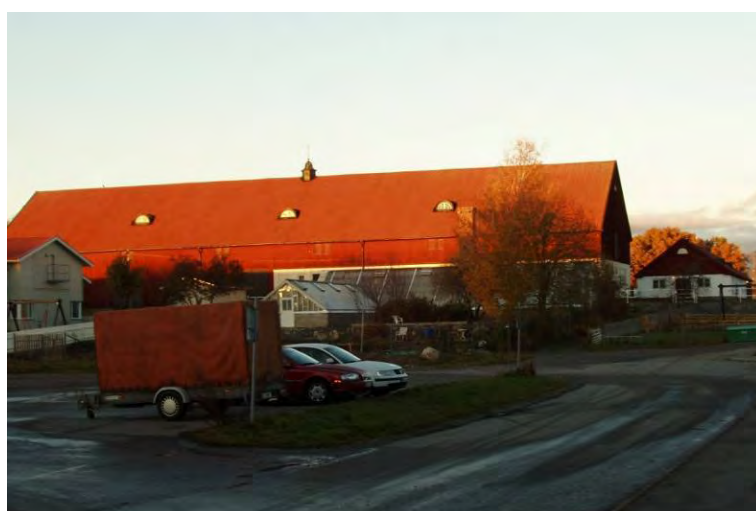
Äldre ekonomibyggnader, Sundby sjukhus
