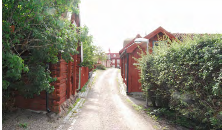
Nordöstra delen runt Bergsgränd med lägre bebyggelse och grusbelagda gator.
