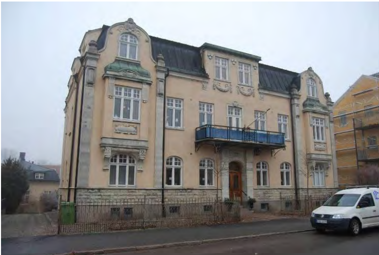
Individuellt utformade friliggande bebyggelse, Kv Åkern 11
