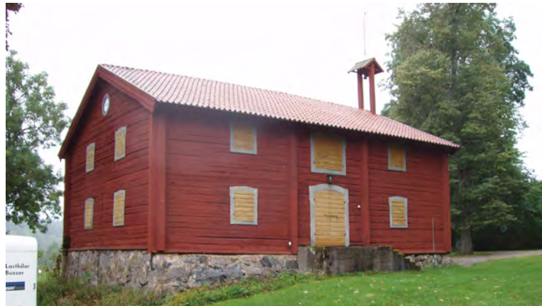
Äldre ekonomibyggnad, Söderlänna säteri
