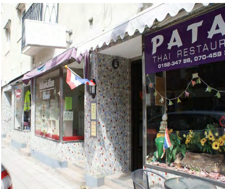
Storgatans mitt med inslag av bebyggelse från 1950-60-tal med tidstypiska detaljer, mosaik, rostfritt stål, smidesbalkonger, kv Priorn.
