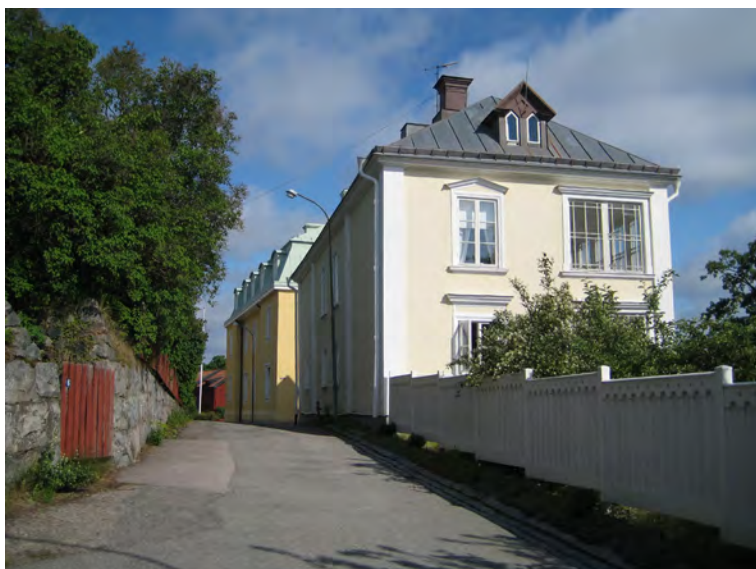
Kv Nabben, Lasarettsgård
