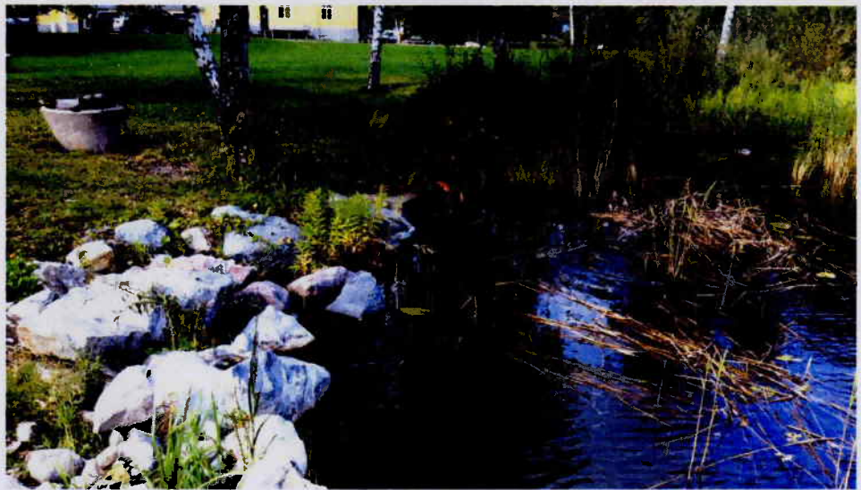
Bild 2 Strand norr om brygga med block som erosionsskydd
