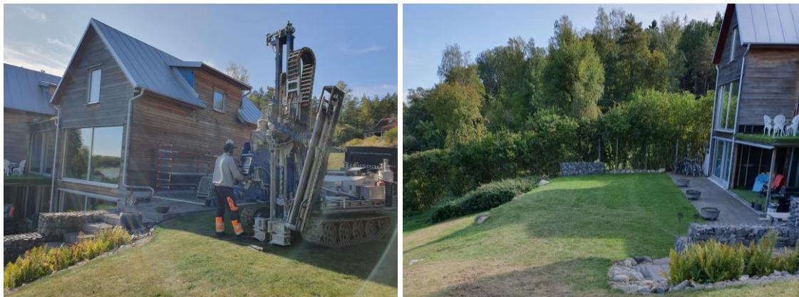
Bild 3.7 – 3.8: Bilderna visar sondering i borrhunkt 1 samt slänten närmast invid fastigheterna Kråkvilan 1:20 och 1:21.
