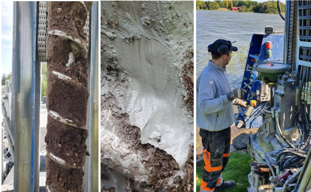
Bild 3.4 – 3.6: Bilderna visar exempel på upptagna skruvprover samt pågående vingborrprovtagning.
