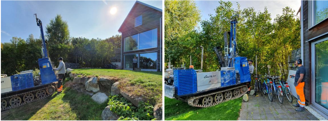
Bild 3.9 – 3.10: Bilderna visar sondering i borrpunkt 5 och 7 samt slänten närmast invid fastigheterna Kråkvilan 1:20 och 1:21.
